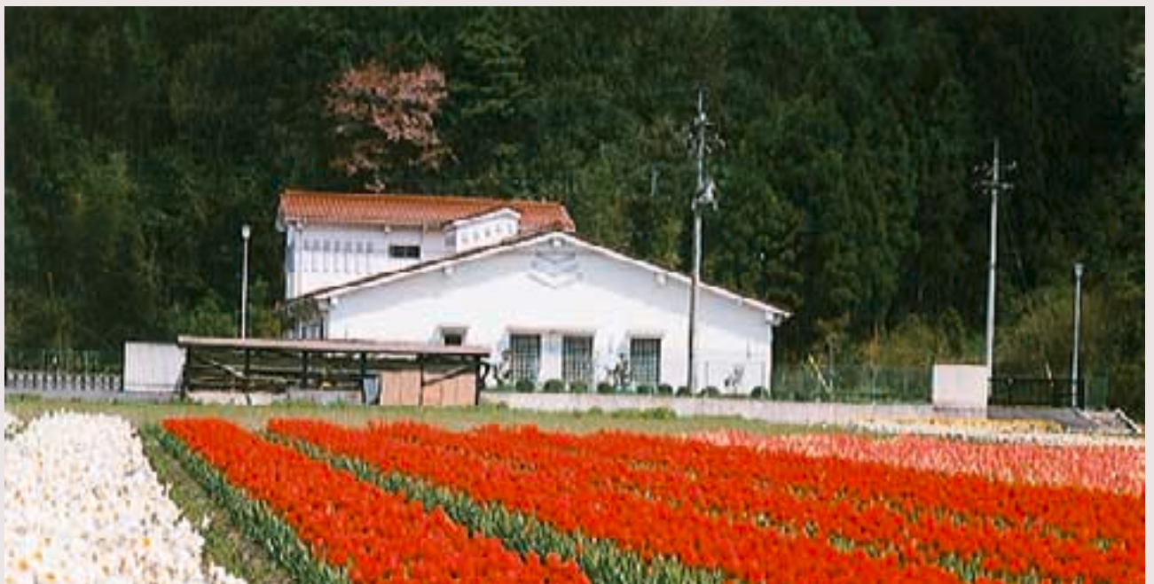
母里地区の農業集落排水汚水処理施設
