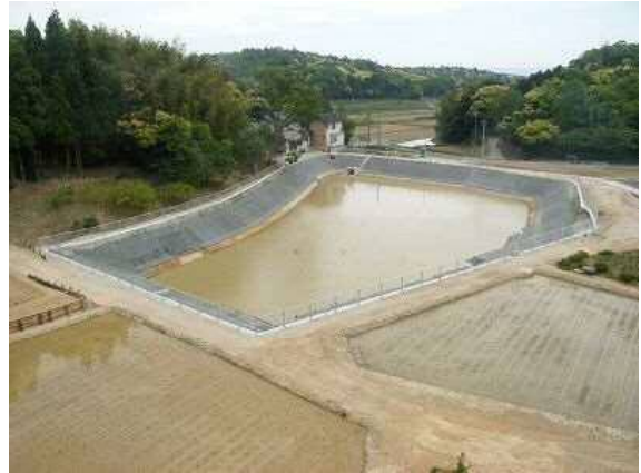
岡本地区 奥廻田池
