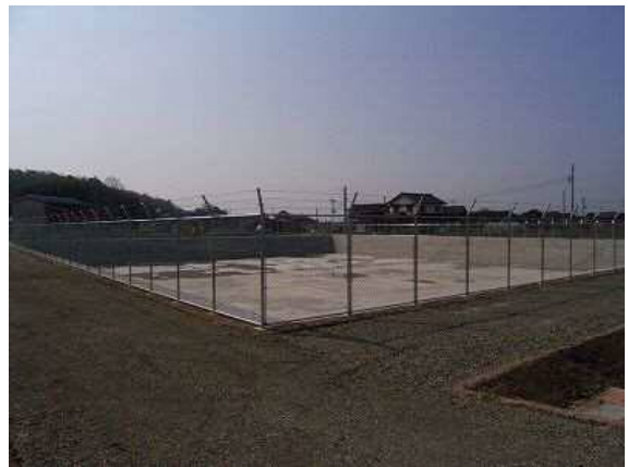
赤江荒島地区 調整池
