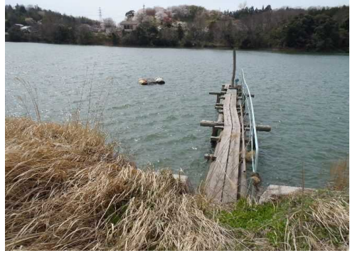
サイフォン全景（フロート、栈橋）
