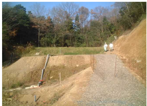
配管 (下流側法面部)
