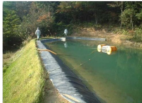
配管 (フロート部～堤頂部)
