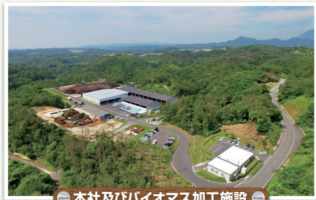
本社及びバイオマス加工施設
