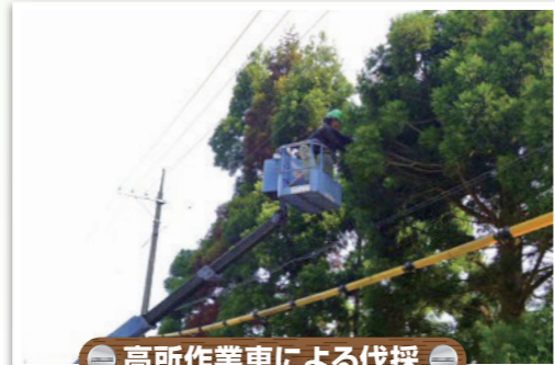
高所作業車による伐採
