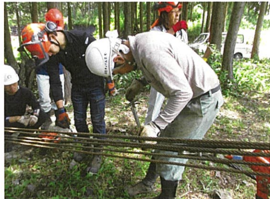
□ ヒールラインによる主索張り上げ・固定
