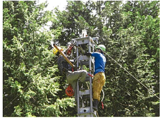
□ 元柱への滑車等設置
