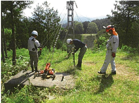
□ 先柱の控索のクリップ設置
