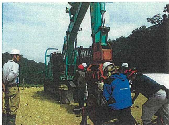
□ ワイヤロープ巻き取り（ワイヤロープの取り扱い）
