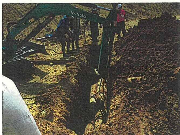
□ 元柱アンカー設置
