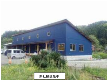
新社屋建設中
