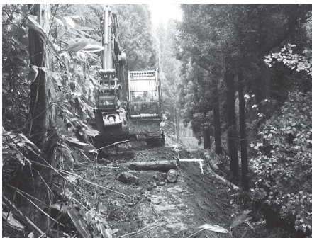
路網設計・施工技術研修
