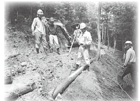
林業エンジニア研修 （路面処理の丸太組設置）
