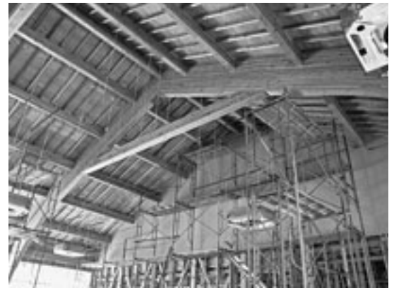
（新庁舎屋根裏部分）
