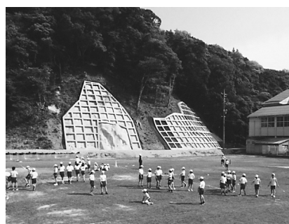
治山施設（山腹工）
