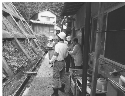
山地防災ヘルパーと県職員による点検
