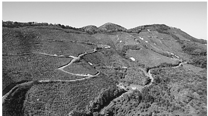
〔林道、作業道が連携した高密度路網施業地〕
