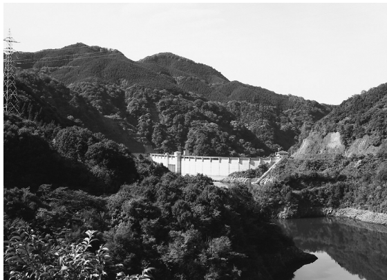
「大長見ダム」浜田市 水源かん養保安林
