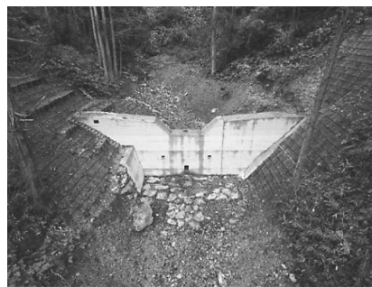
治山施設（谷止工）
