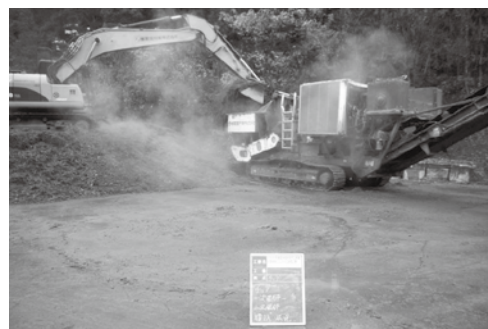
〔現地発生材有効利用のためのチップ化〕
