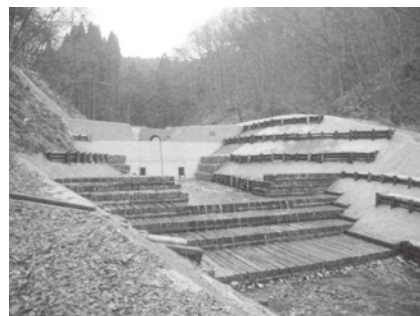
治山施設（谷止工）
