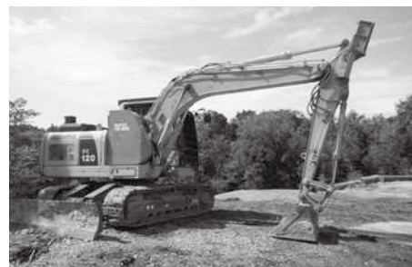
写真) スイングヤード
