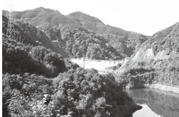
「大長見ダム」 浜田市 水源かん養保安林
