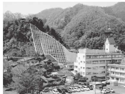
治山施設（山腹工）
