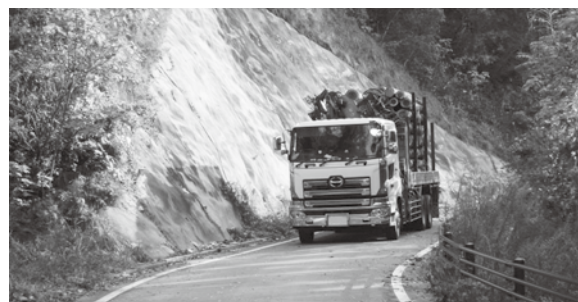
〔林道の利用状況〕
