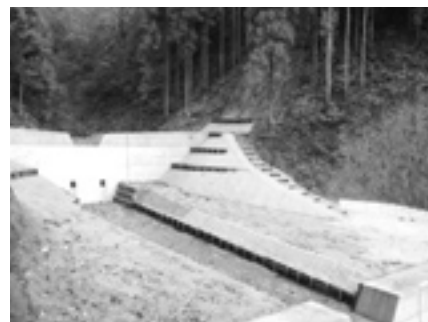
治山施設（治山ダム工）
