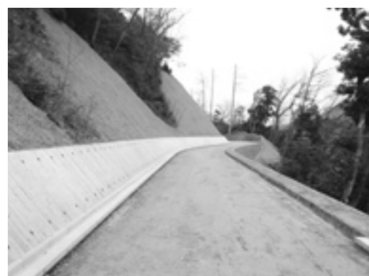
〔現地発生材利用の吹付と補強土壁を採用した林道〕
