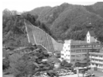
治山施設（山腹工）
