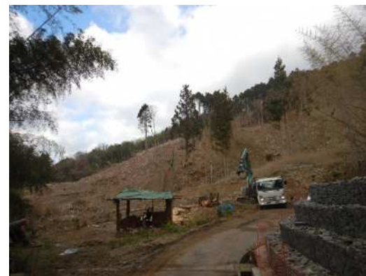
（経営管理実施権に基づく森林整備）
