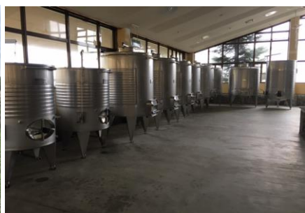
改装中の醸造設備
