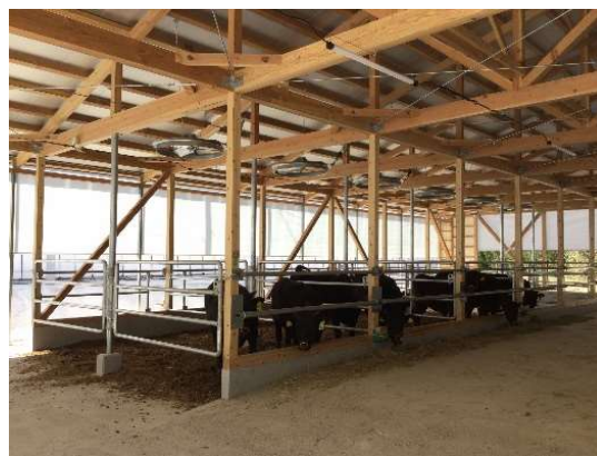
増築した繁殖牛舎(内部)
