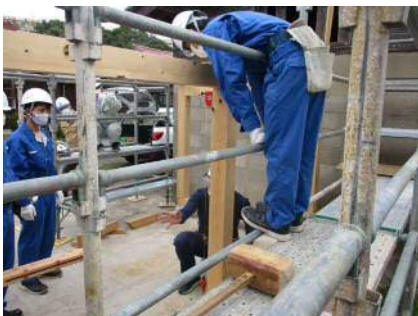
農機具庫建設の様子
