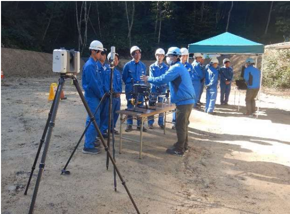
施工業者によるICT機器の説明
