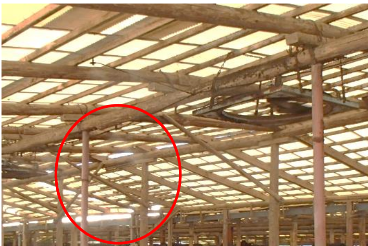
換気扇と霧（ミスト）による暑熱対策の一例
