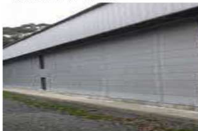
(例:鶏舎外壁修繕)
