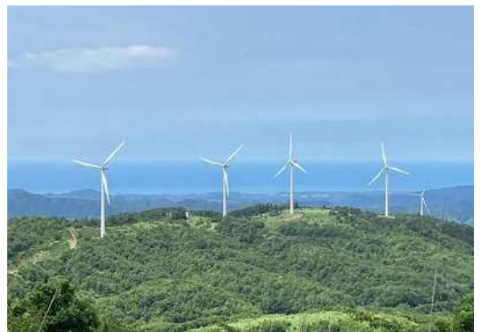
〈風力発電施設（保安林解除）〉
