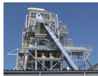
< 木質バイオマス発電所 >
