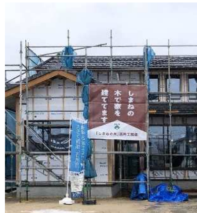
〈県産木材を使用した木造住宅〉
