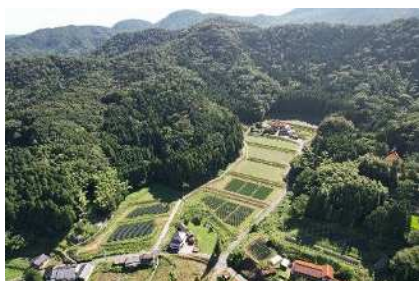
〈中山間地のほ場整備〉
