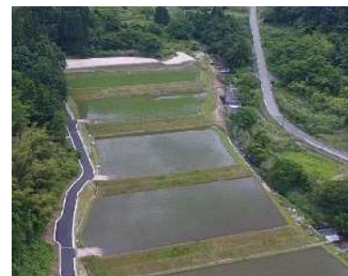
〈中山間地域の小規模なほ場整備〉
