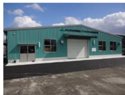
〈調製・出荷作業を受託する共同選果場を整備（アスパラガス）〉
