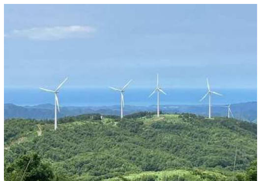
〈風力発電施設（保安林解除）〉
