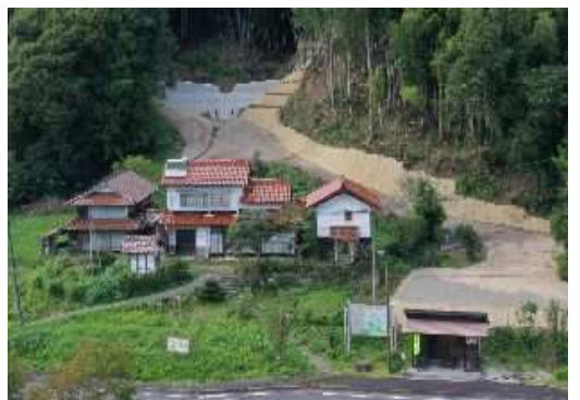
〈治山ダムにより保全された人家〉
