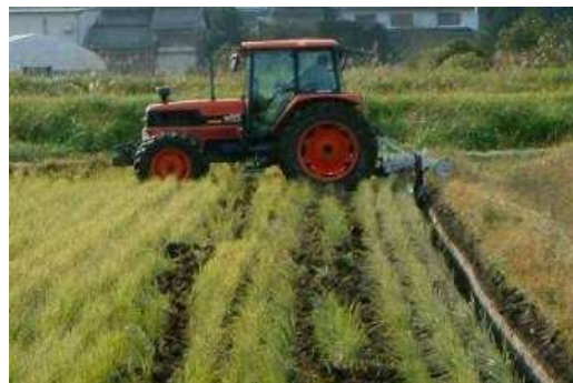
第2図 弾丸暗きょ(額縁明きょの底面から施工)
