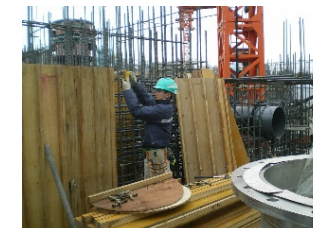
【コンクリートを流し込むための型枠を組む作業の様子】
