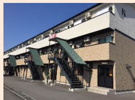
新設した外国人専用の寮 (外観)
