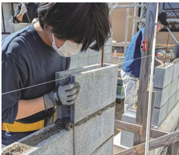
基礎の上にコンクリートブロックを積んでいる状況です。ブロックの場所を合わせるの難しい作業です。
