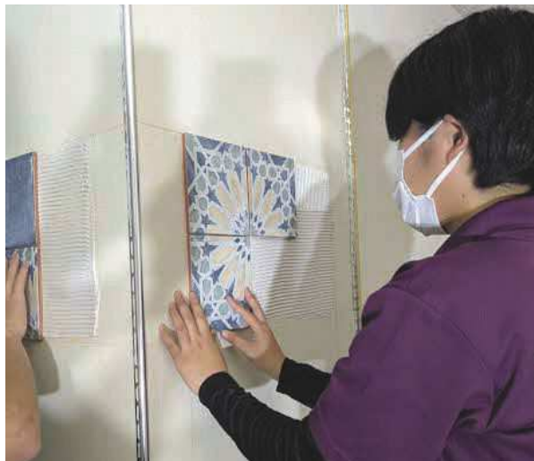
実習棟の廊下でタイル実習の写真です。
