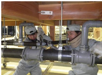
配管施工実習(ビルの配管は大きいです)
