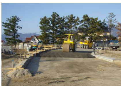
土木施工実習(実際に道路を作ります)
