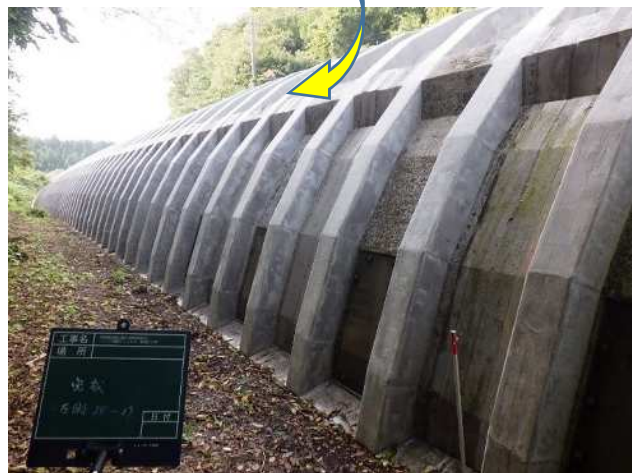
スノーシェルター 横梁修繕
