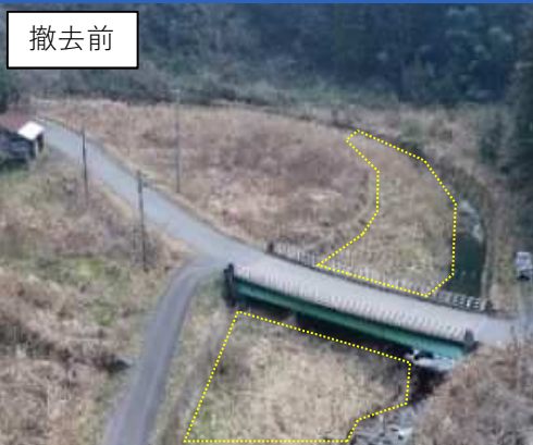
堆積土砂撤去
