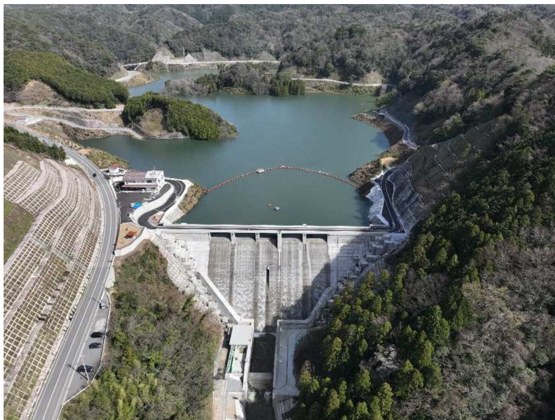
波積ダム試験湛水状況 (下流側より)
