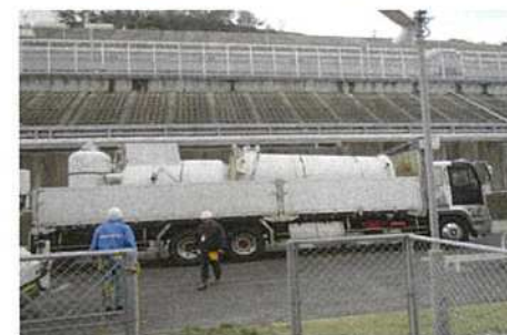
解体物の移送
