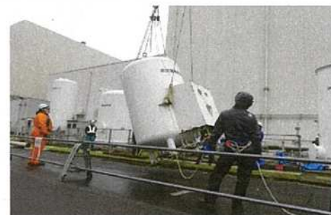
撤去作業の状況
