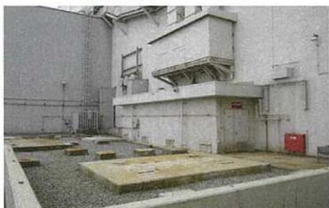
撤去作業後の状況
