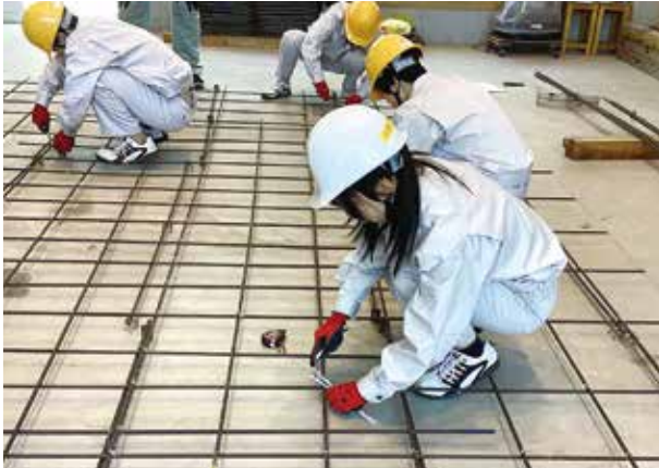
建築コース：床スラブ配筋の実習
