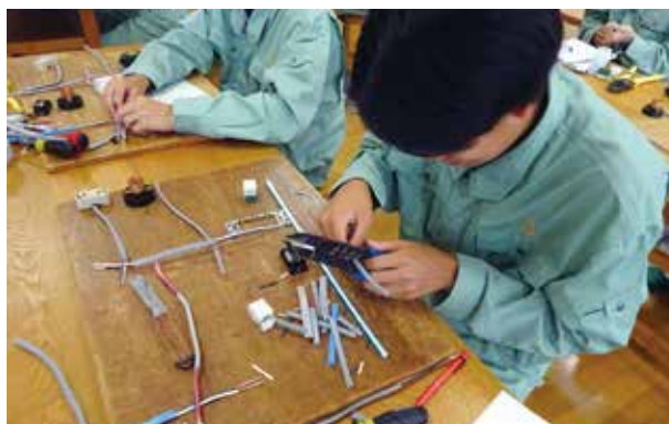
電気工事実習
