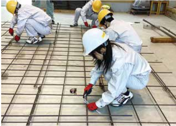
建築コース：床スラブ配筋の実習
