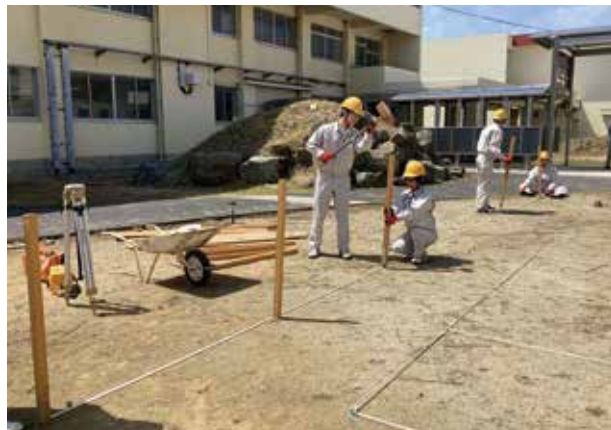
建築コース：縄張り・水盛・遣方実習
