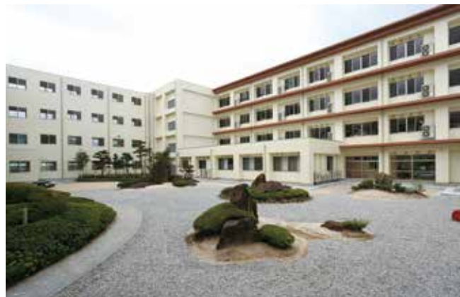
平成 27 年 7 月に完成した新校舎
