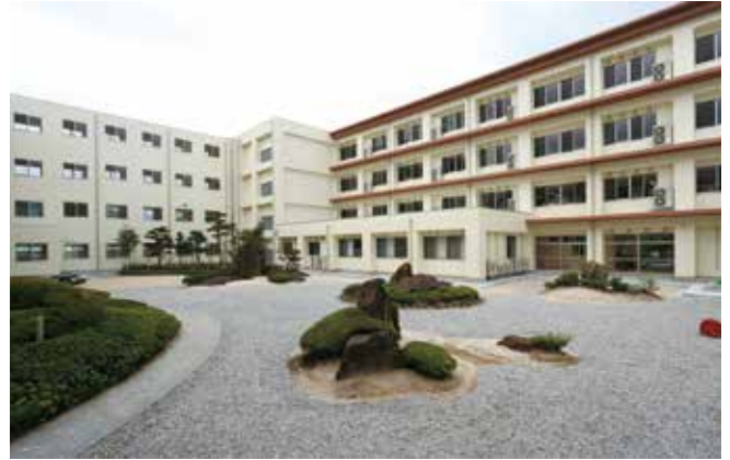
平成 27 年 7 月に完成した新校舎
