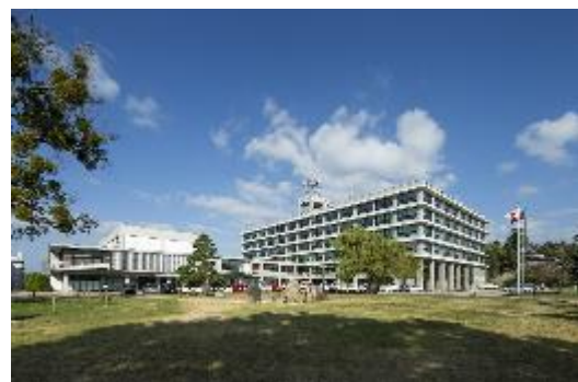
島根県庁舎 本庁舎（右）・議事堂（左）
