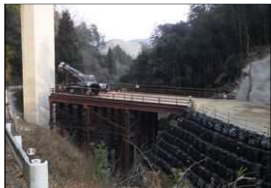
橋脚RC巻立（構台設置状況）
