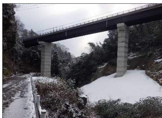
橋脚RC巻立（竣工後）
