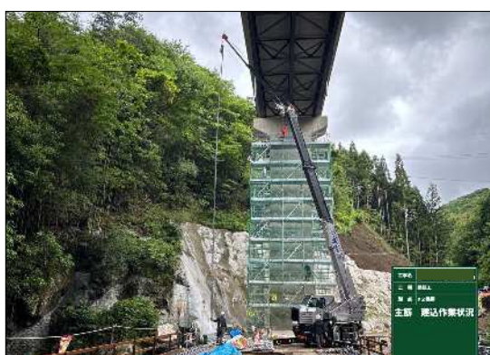
橋脚RC巻立（大型機械での施工状況）
