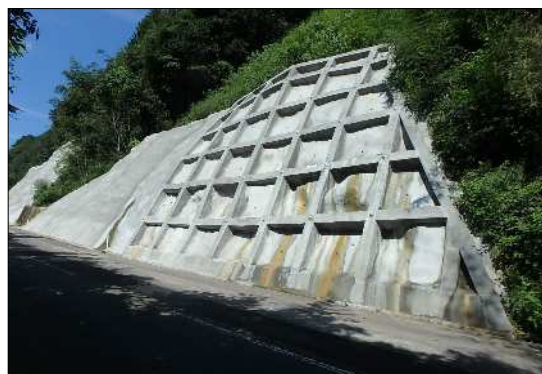
法面修繕工（竣工後）
