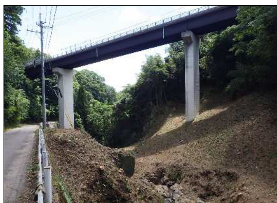
橋脚RC巻立（着工前）
