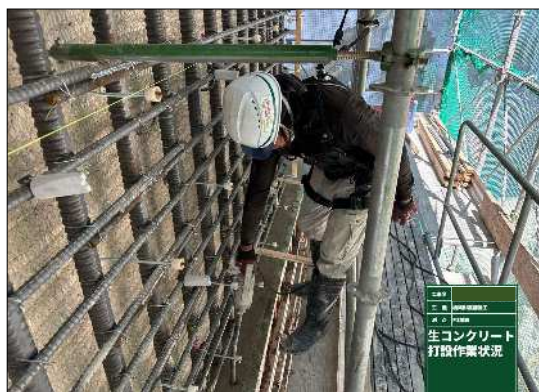
橋脚RC巻立（施工状況）
