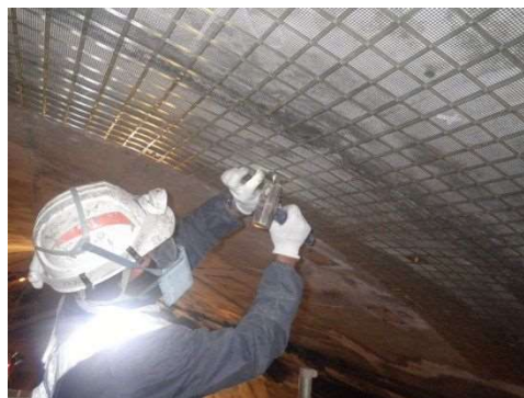
写真 3-1 FRP ネット設置状況
