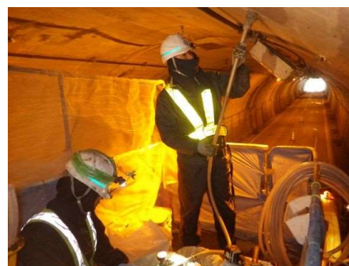
裏込注入状況
