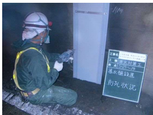
写真 3-2 線導水工
