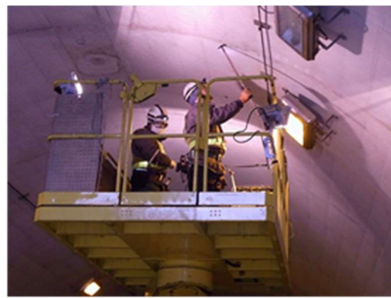
写真 2-1 トンネル点検状況
