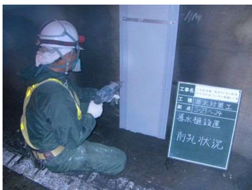
写真 3-2 線導水工
