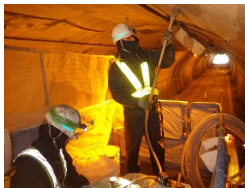
裏込注入状況
