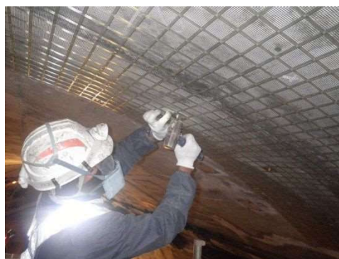
写真 3-1 FRP ネット設置状況
