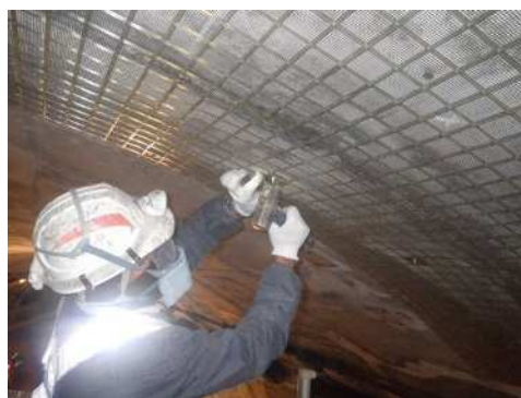
写真 3-1 FRP ネット設置状況
