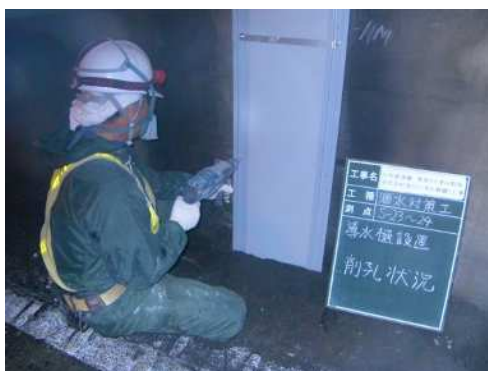
写真 3-2 線導水工
