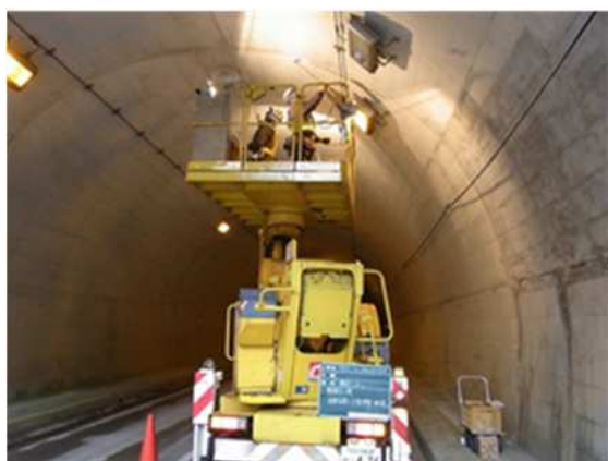
写真 2-1 トンネル点検状況
