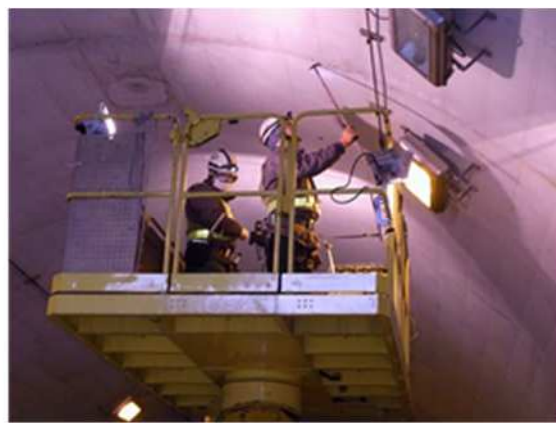
写真 2-1 トンネル点検状況
