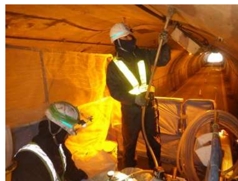
裏込注入状況
