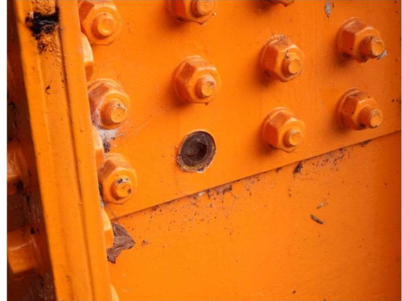
取付ボルト (F11T) の破断
