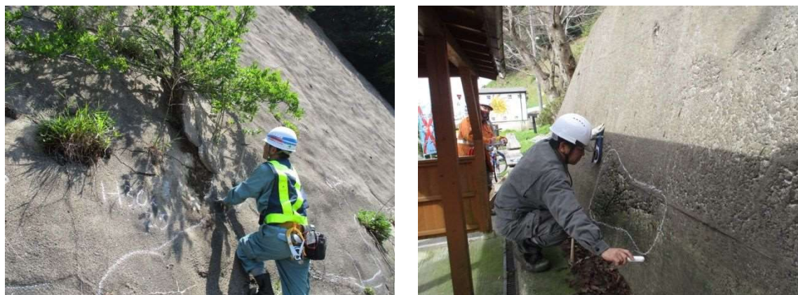
写真 2-1 法面構造物点検状況
