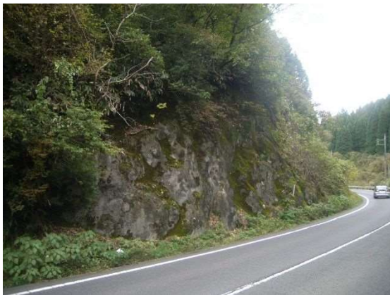
写真 3-1 既設モルタルの撤去＋再吹付
