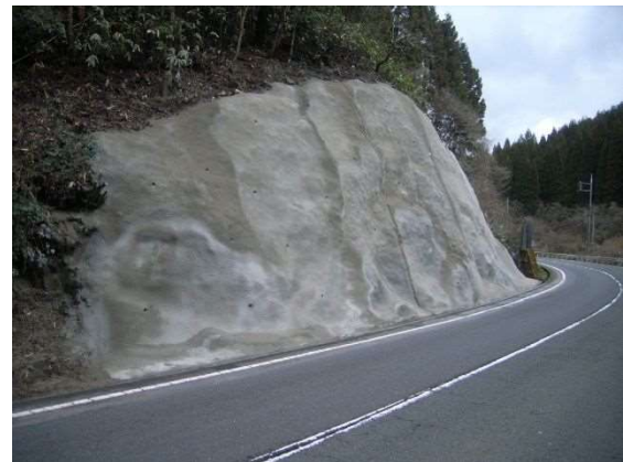
写真 3-1 既設モルタルの撤去＋再吹付
