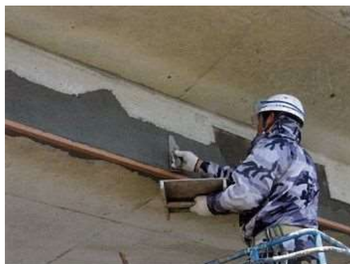
写真 4-3 断面修復状況
