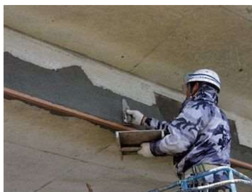
写真4-3 断面修復状況
