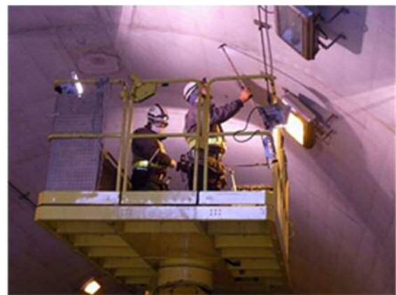
写真 2-1 トンネル点検状況
