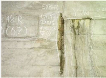
平成28年度点検:健全度Ⅲ (主)浜田八重可部線(坂本トンネル)
