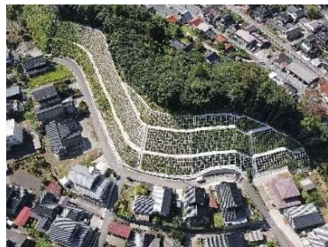
唐井地区 急傾斜地崩壊対策事業(隠岐の島町) 【人家16戸、町道の保全】
