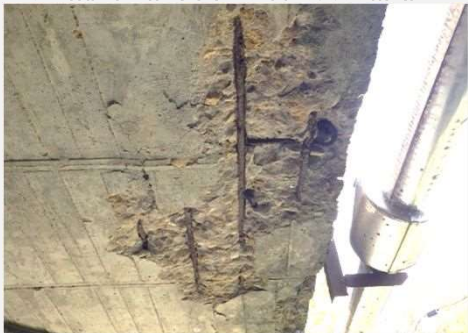
平成29年度点検:健全度Ⅲ (一)八重垣神社八雲線(中組橋)
