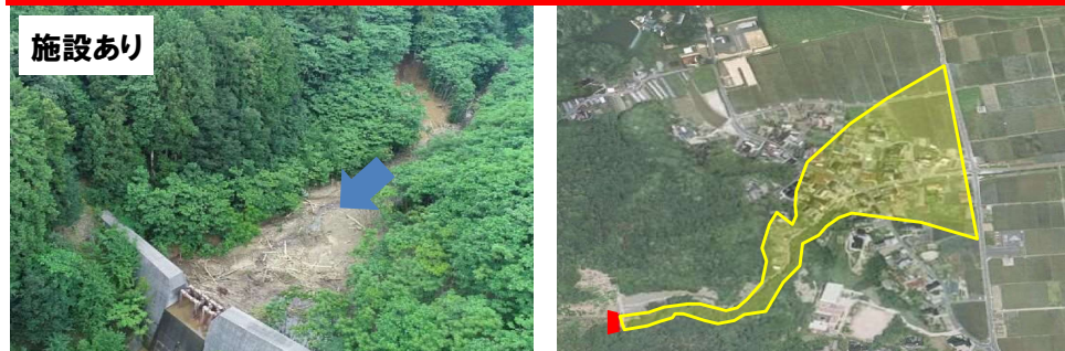
砂防堰堤による土砂捕捉
