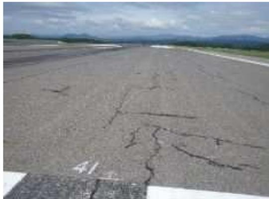
写真－5 滑走路ひび割れ発生状況
