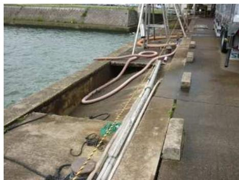
写真－１２ 上部工の陥没
