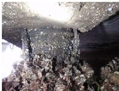
写真－１４ 杭頭部の腐食
