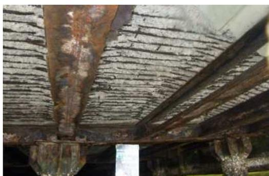
写真－１３ 上部工の劣化（下面側）
