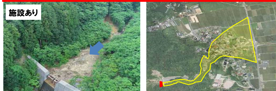
砂防堰堤による土砂捕捉
